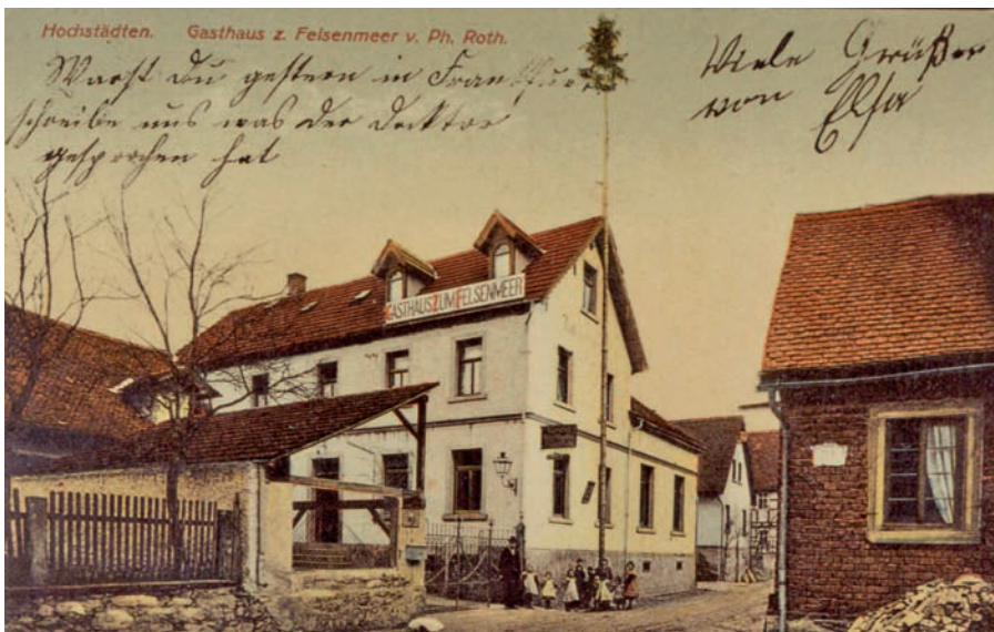
Abb. 1: Das Haus Mühltalstraße 268, ehemalige Gasthaus „Zum Felsenmeer“ der Familie Roth
